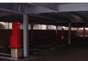
全車避難でガラ空きになった地下駐車場(7月14日午前7時02分)
